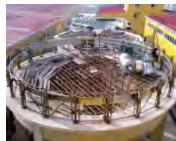
02 施工现场设备定位 Construction site equipment location
